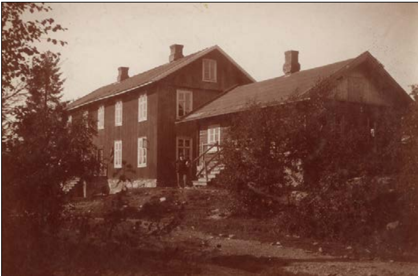
Familiebrakka ved Brøstadgruva med åtte små leiligheter. Til høyre står kontorbrakka der administrasjonen holdt til. Det var en smal passasje mellom de to husene.
