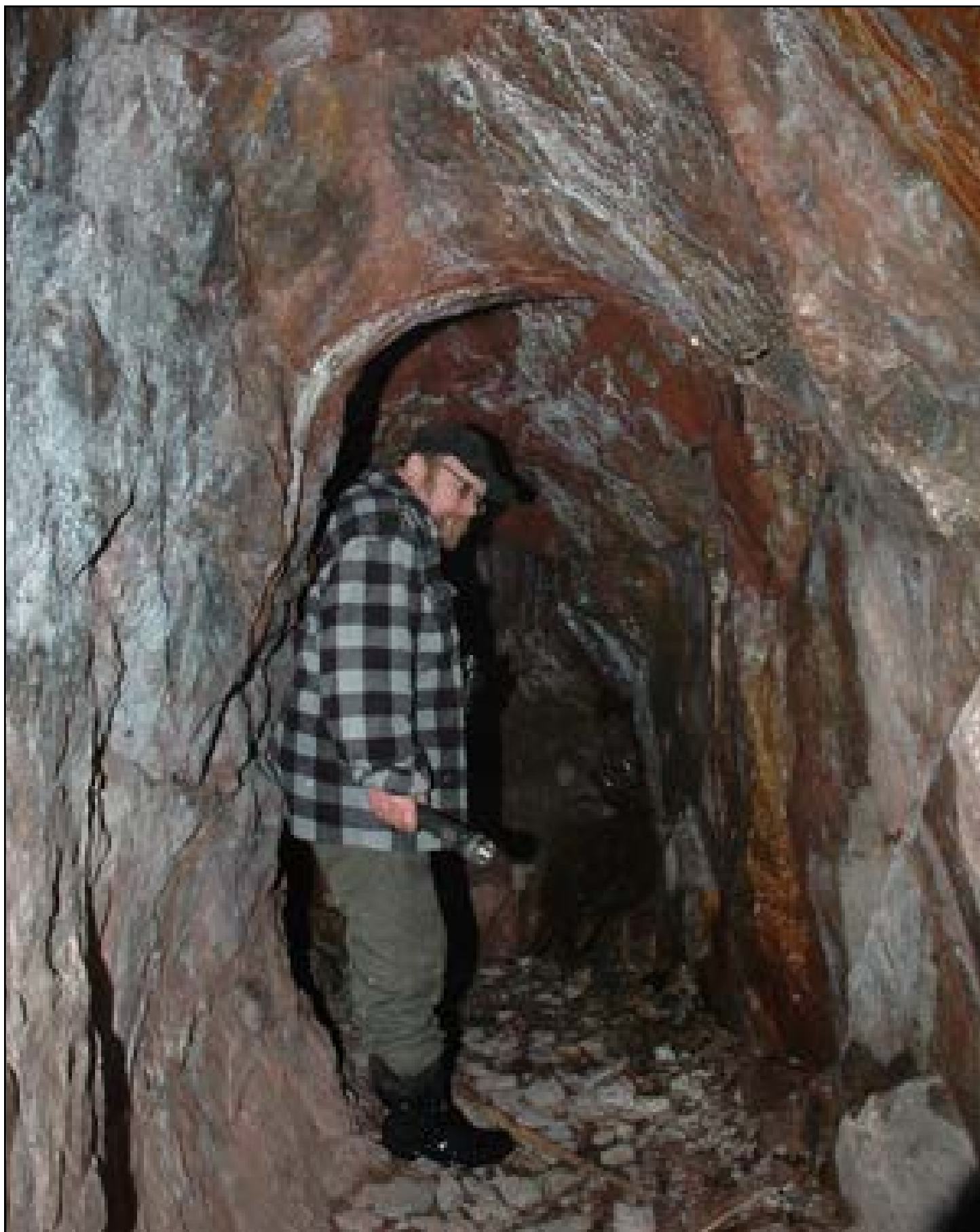
Den 17 meter lange stollen i Utsjøgruva er tatt ut ved hjelp av fyrsetting. Mannen på bildet er kjentmann Bjørn E. Kittelsen.
