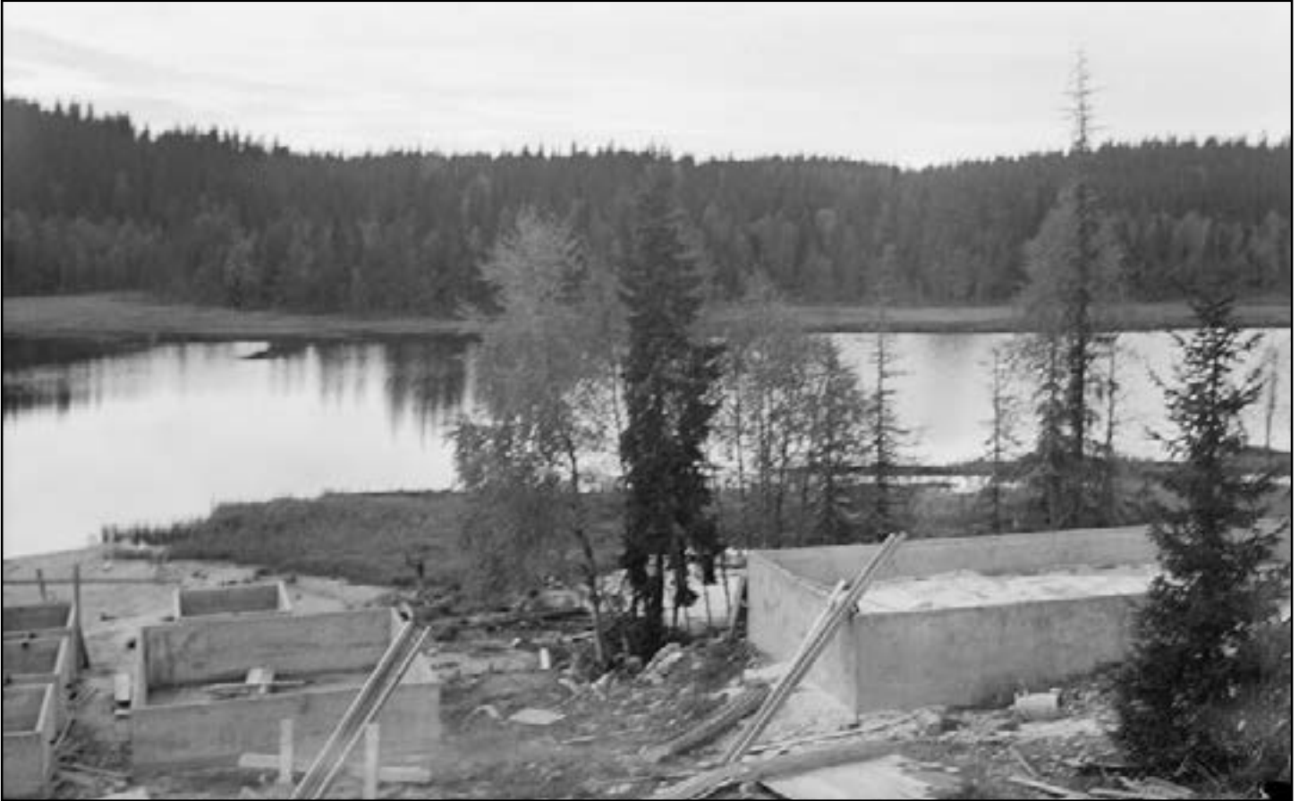
Betongkummene ved skogstjernet Putten ble bygd midt på 1930-tallet under forsøket på å utvinne mer gull fra vraksanda etter engelskmennenes gruvedrift.
