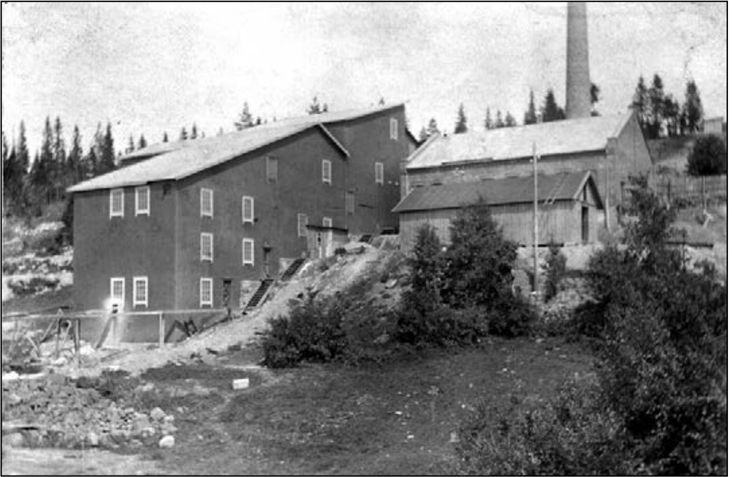
Fabrikken sett fra bunnen av lia og nord-østover. Bygningen bakerst til høyre er maskinhuset. Funksjonen til bygningen foran er ukjent. Den store bygningen til venstre er selve oppredningsverket med vaskeriet nederst.
