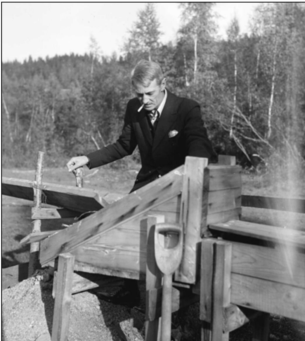
Vaskerenne brukt i forbindelse med omvasking av sanda fra oppredningsverket midt på 1930-tallet. Mannen på bildet er Ivar Brandt, daværende eier av det opprinnelige gruvesmåbruket Glabakk i Gullverket. (Foto: Aftenposten)
