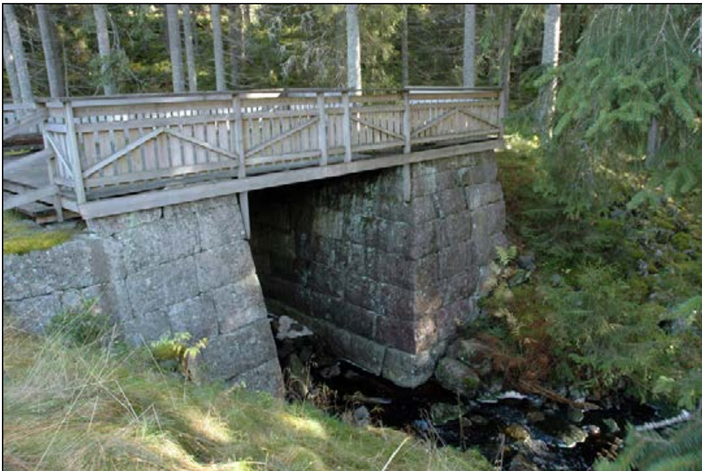
Her stoppet ruveselskapets jernbaneplaner, ved brua over Røisitjernsbekken ved Røisivangen.
