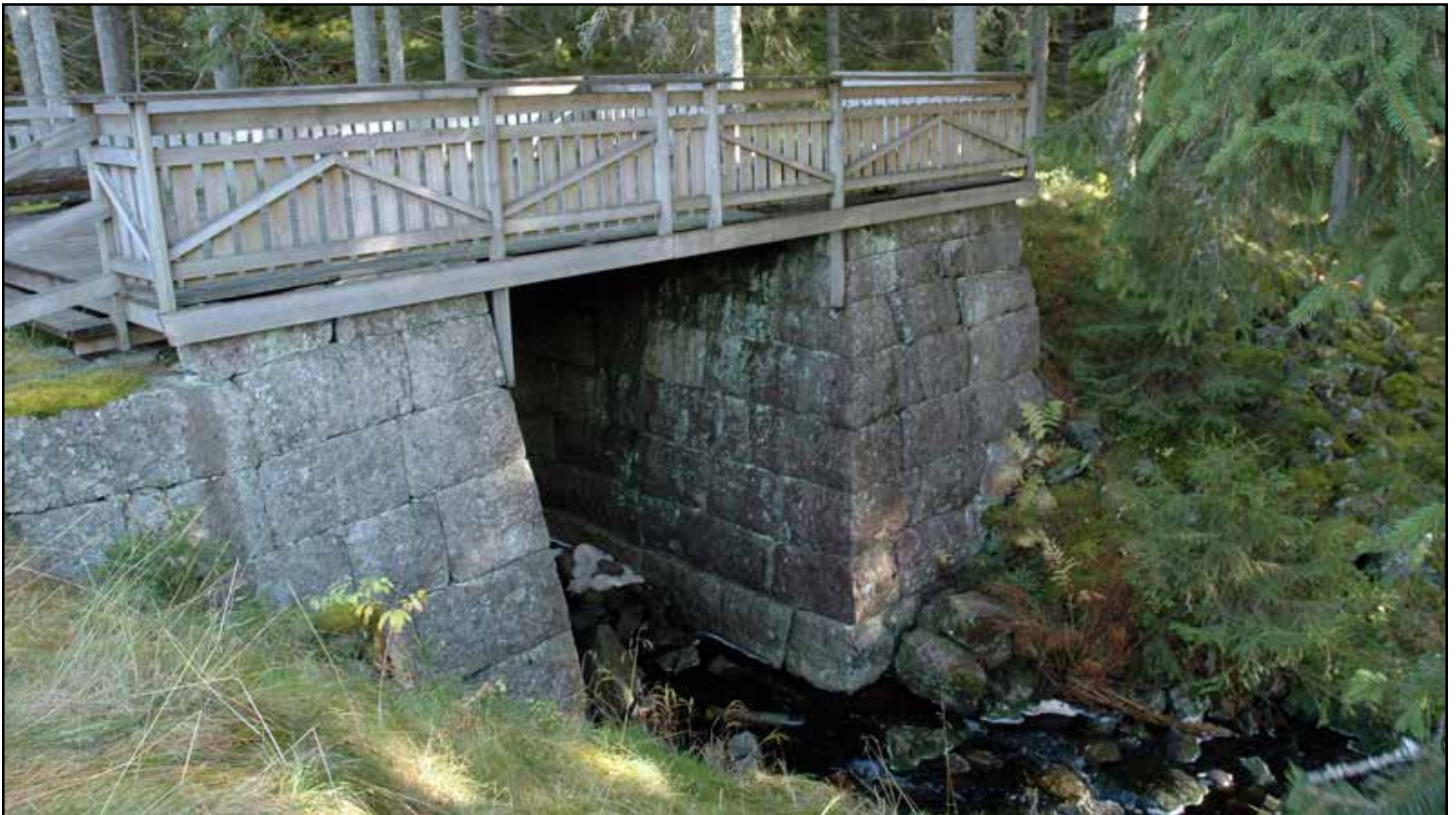
Her stoppet gruveselskapets jernbaneplaner, ved brua over Røisitjernsbekken ved Røisvangen.
