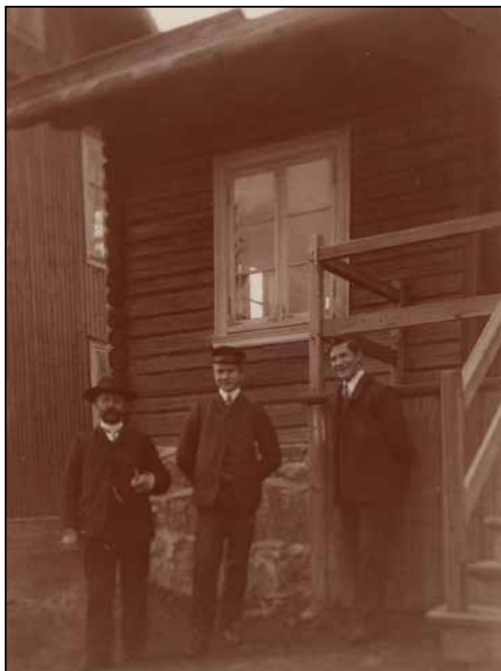
Bilde tatt utenfor kontorbrakka på Brøstadgruva, trolig i 1906. Familiebrakka skimtes til venstre. Til venstre står kontorsjef Ole Berger, i midten Bergers svoger Rolf Strøm og til høyre en engelskmann som trolig er kjemikeren Mr. Withy. (Originalen tilhører Thorunn Grammeltvedt, Langhus og Trond E. Berger, Ås).
