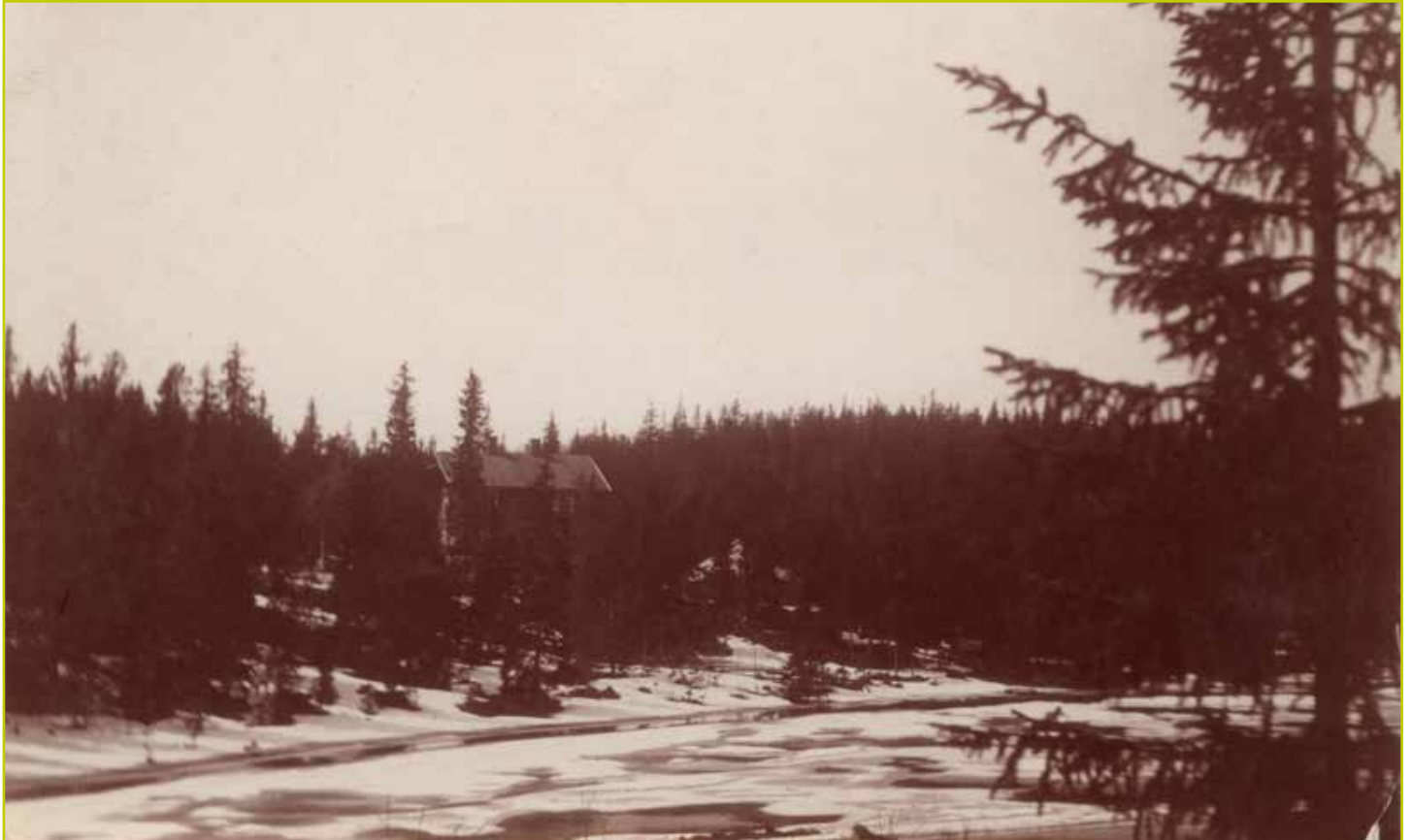
Kapteingården sett fra andre sida av Røvatnet.
