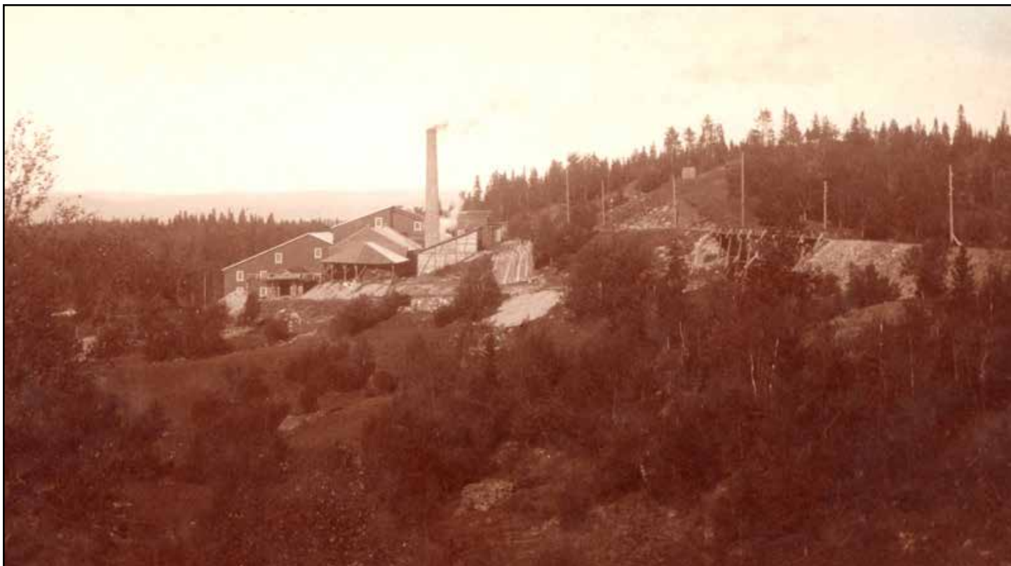
Oversikt over anlegget på Brøstadgruva med oppredningsverk midt på bildet og jernbanen mot gruva til høyre.
