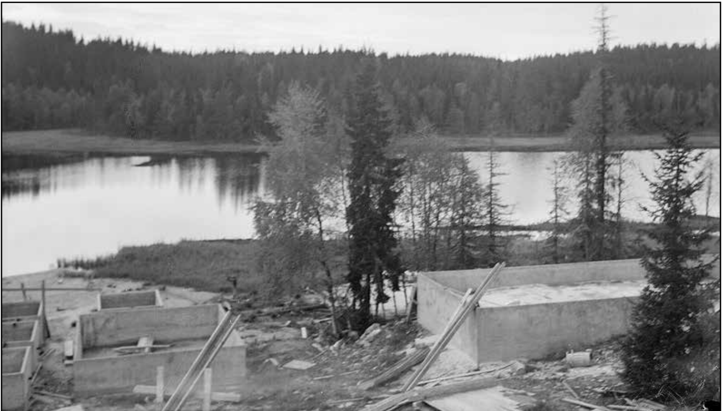
Betongkummene ved skogstjernet Putten ble bygd midt på 1930-tallet under forsøket på å utvinne mer gull fra vraksanda etter engelskmennenes gruvedrift.
