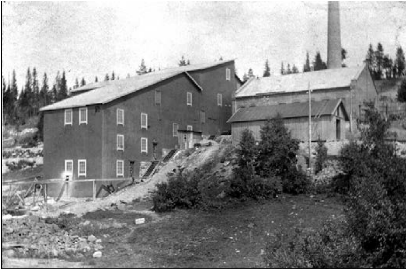
Fabrikken sett fra bunnen av lia og nord-østover. Bygningen bakerst til høyre er maskinhuset. Funksjonen til bygningen foran er ukjent. Den store bygningen til venstre er selve oppredningsverket med vaskeriet nederst.
