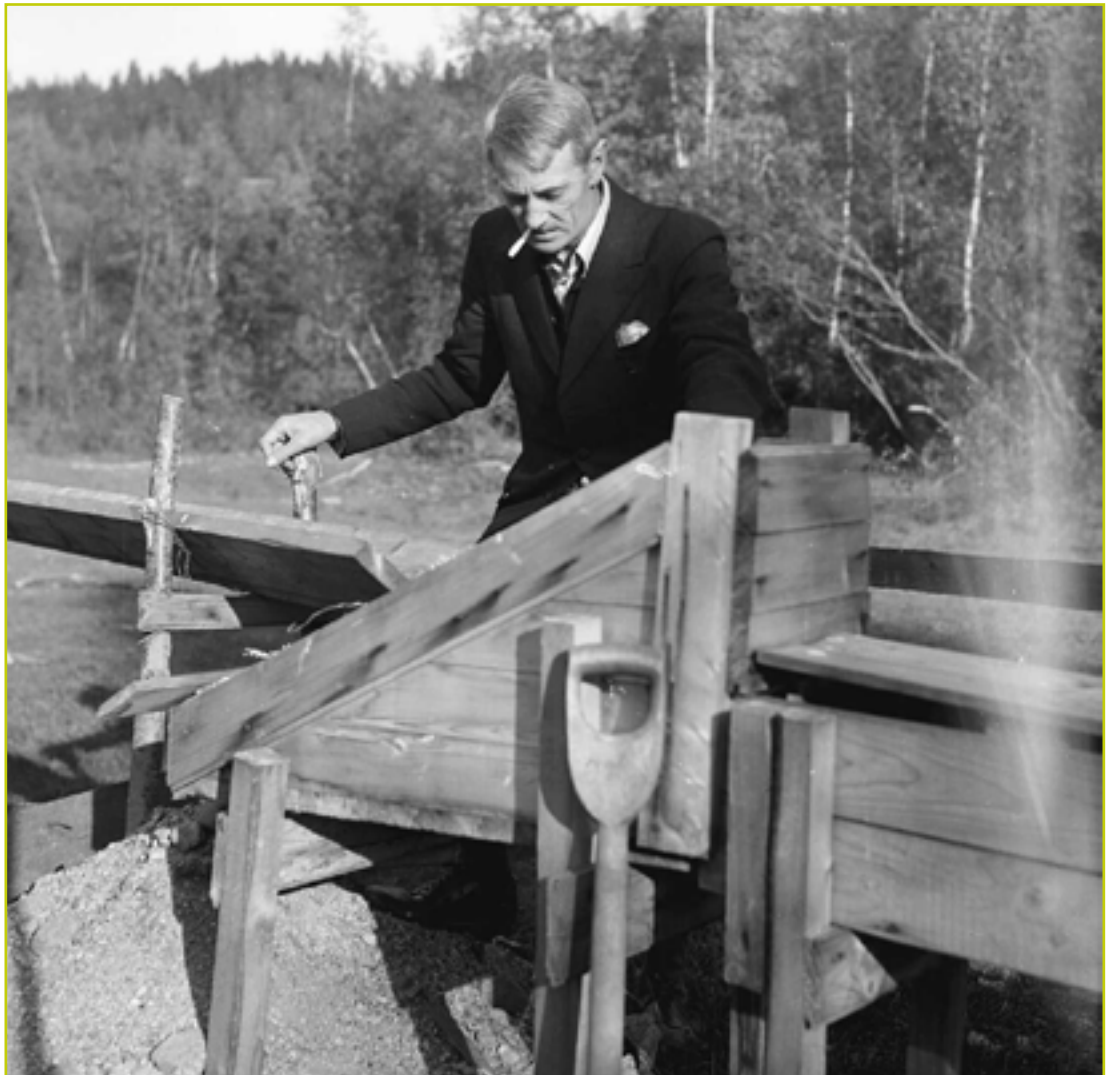
Vaskerenne brukt i forbindelse med omvasking av sanda fra oppredningsverket midt på 1930-tallet. Mannen på bildet er Ivar Brandt, daværende eier av det opprinnelige gruvesmåbruket Glabakk i Gullverket. (Foto: Aftenposten)
