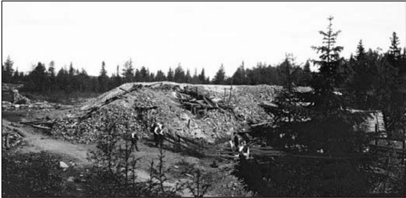
Etter gruvekonkursen i 1907 ble alt av verdi solgt på auksjon. Resten ble stående igjen til forfall. Slik så Synken ut i 1925. (Foto:Norsk Skogmuseum)
