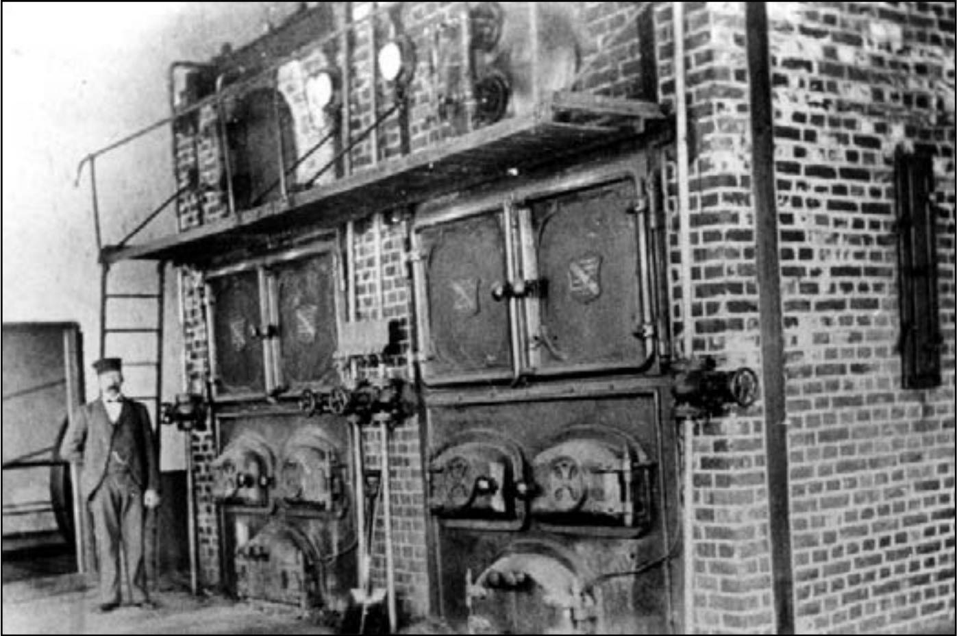
Fyrrommet i det store maskinhuset. Dampmaskinene ble fyrt med kull, importert fra England.
