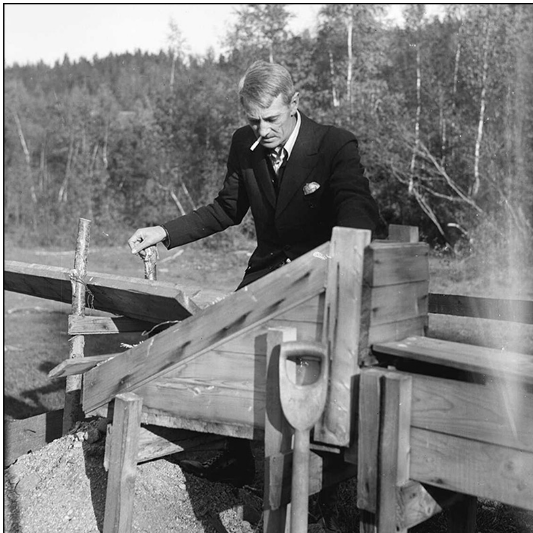
Vaskerenne brukt i forbindelse med omvasking av sanda fra oppredningsverket
