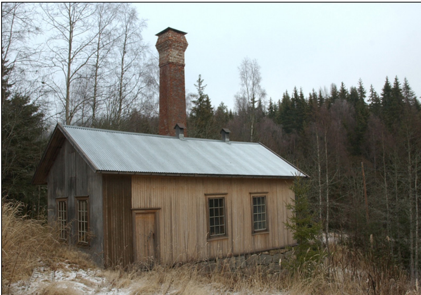
Laboratoriet på Knoffsløkken er den eneste driftsbygningen som står igjen fra gruvetida i Gullverket.
