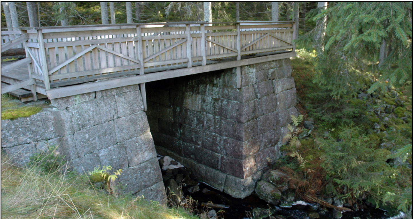
Her stoppet gruveselskapets jernbaneplaner, ved brua over Røisitjernsbekken ved Røisivangen.
