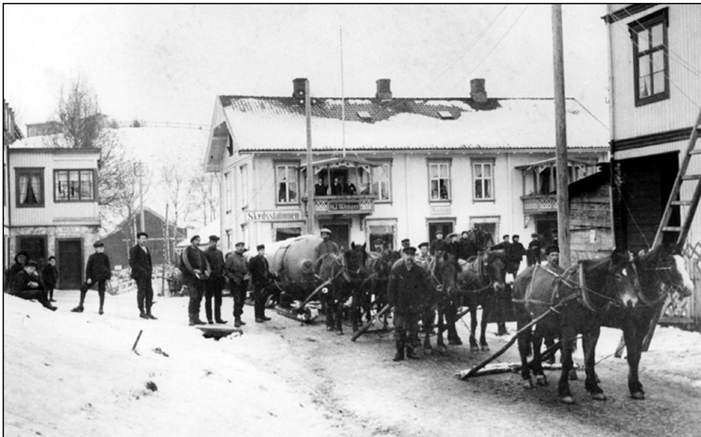
Den store dampmaskinen fra Brøstadgruva fraktes til Eidsvoll stasjon for å bli satt opp igjen ved Vamma kraftverk i Glomma. Seks hester foran dro den tunge dampkjelen. To hester bak ble brukt som brems i bratte nedforbakker. Bildet er tatt i Eidsvoll sentrum.
