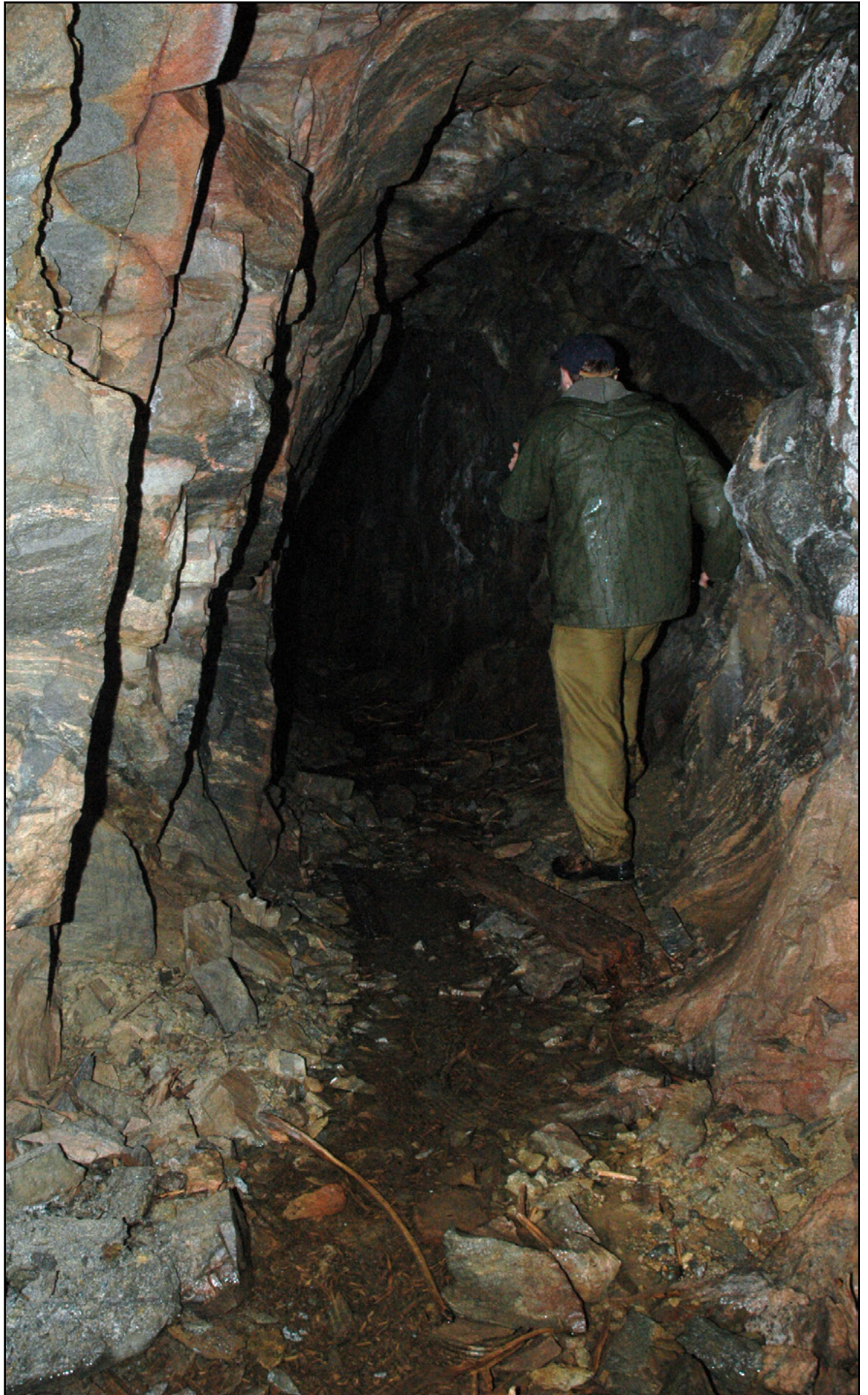
Sandergruva er om lag 30 meter lang og ender i bunnen av en ca. 20 meter dyp sjakt.
