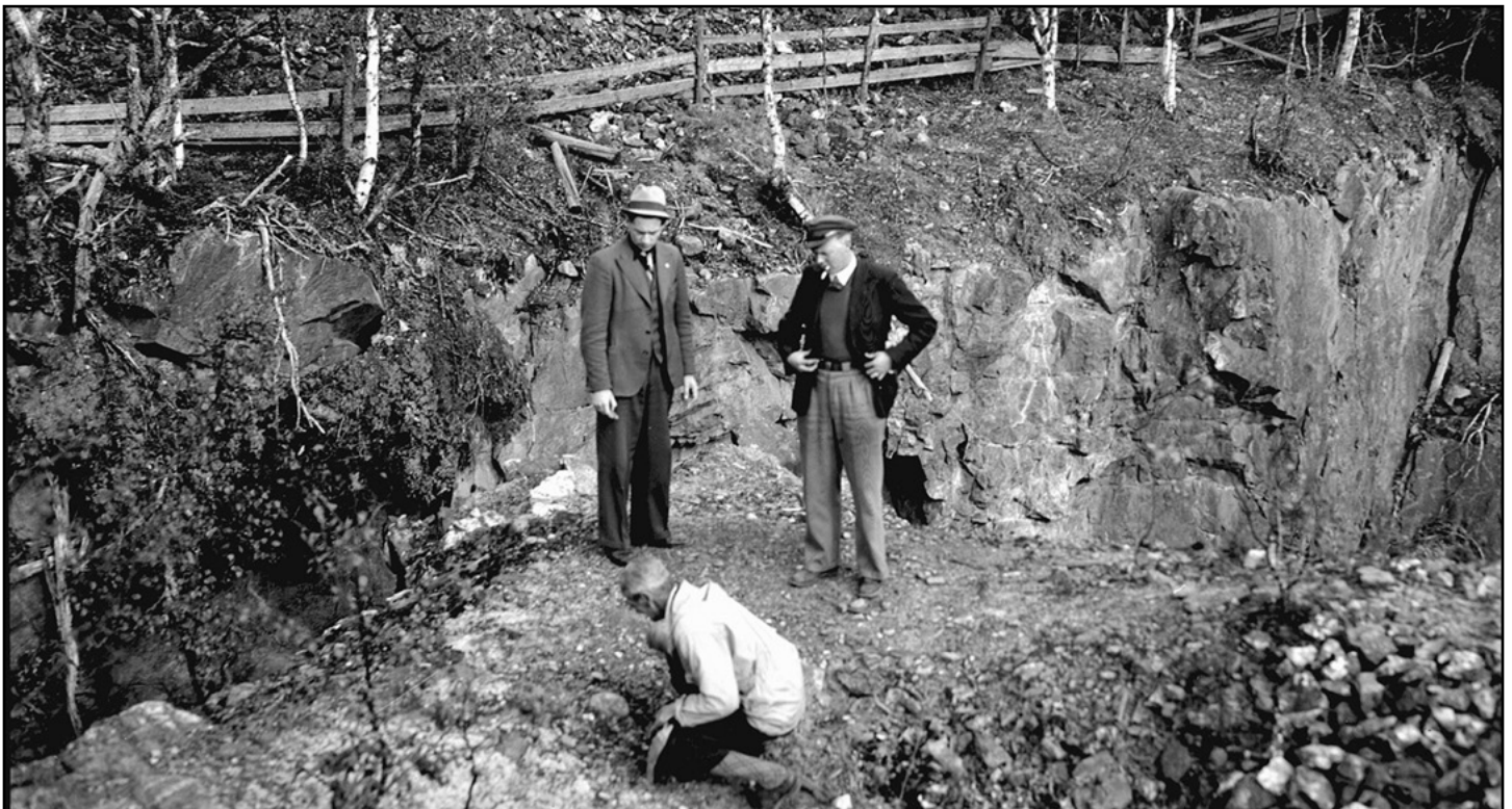
Stullgangen i 1939. Aftenposten er på reportasjetur med Ivar Brandt (foran) som kjentmann. Legg merke til det gamle tregjerdet som er eneste sikring mot gruvegangen. (Foto: Aftenposten)
